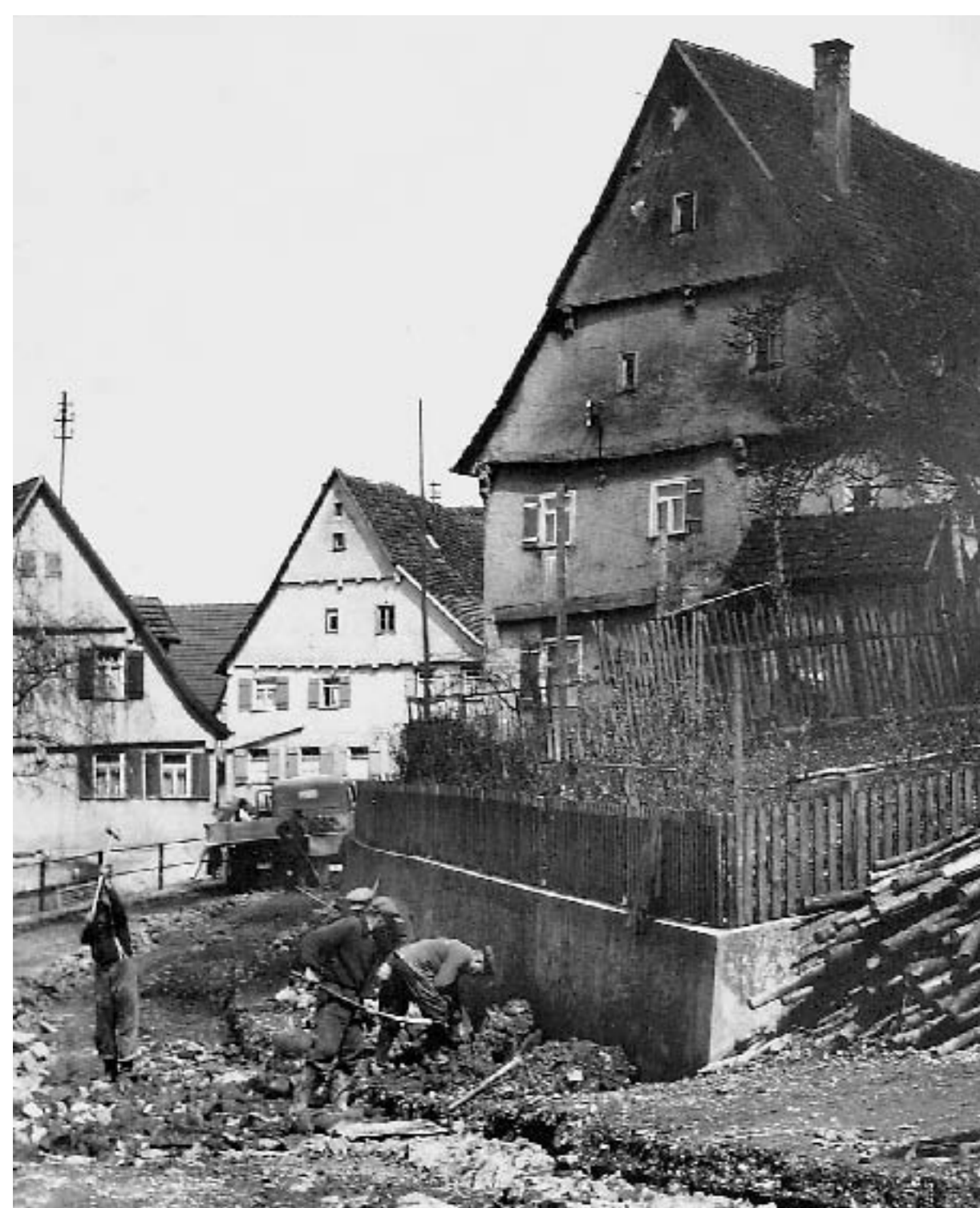
Gehwegarbeiten 1951 beim Haus Brunnenstraße 8
